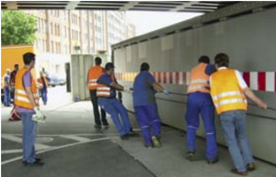
Abb. 25: Überprüfung der Notzugeinrichtung am Hochwasserschutztor Oberhafenbrücke
