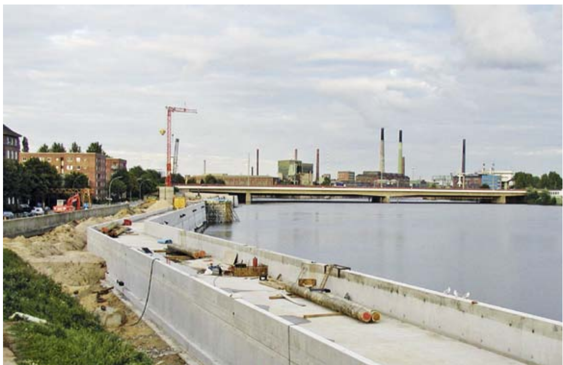
Abb. 16: Bau der Hochwasserschutzwand Am Zollhafen
