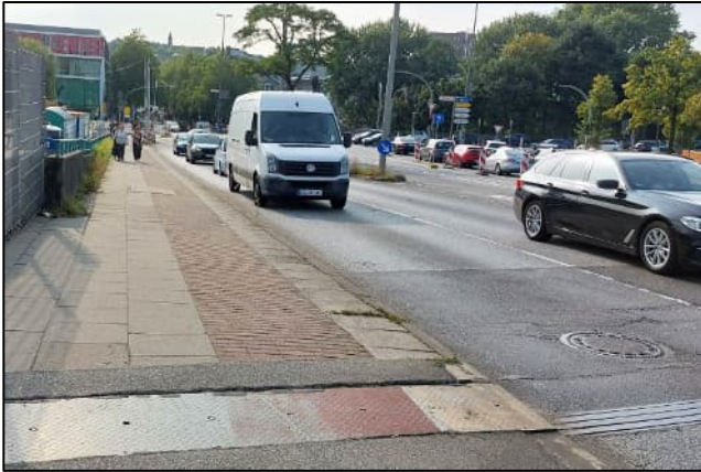
Abb. 20: Walter-Dudek-Brücke, Blick Richtung Westen, südliche Nebenflächen mit untermaßigem Radweg sowie Gehweg
