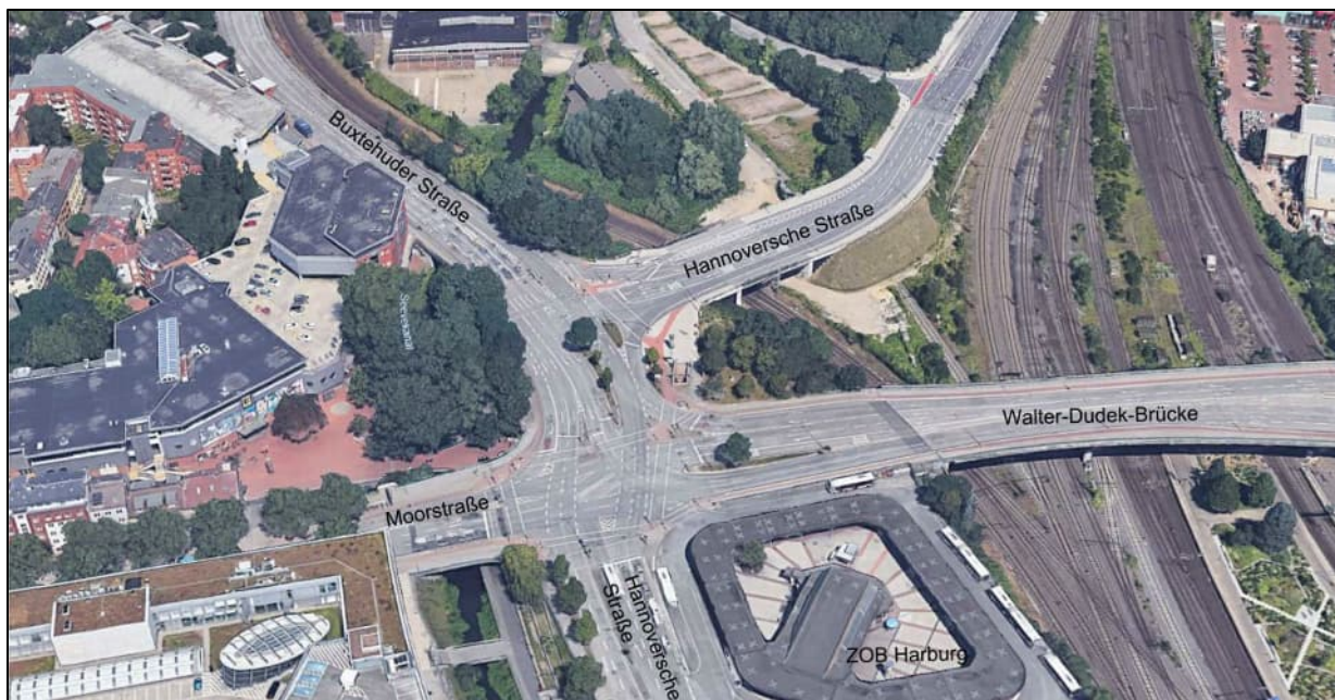
Abb. 8: Luftbild, von Süden gesehen
