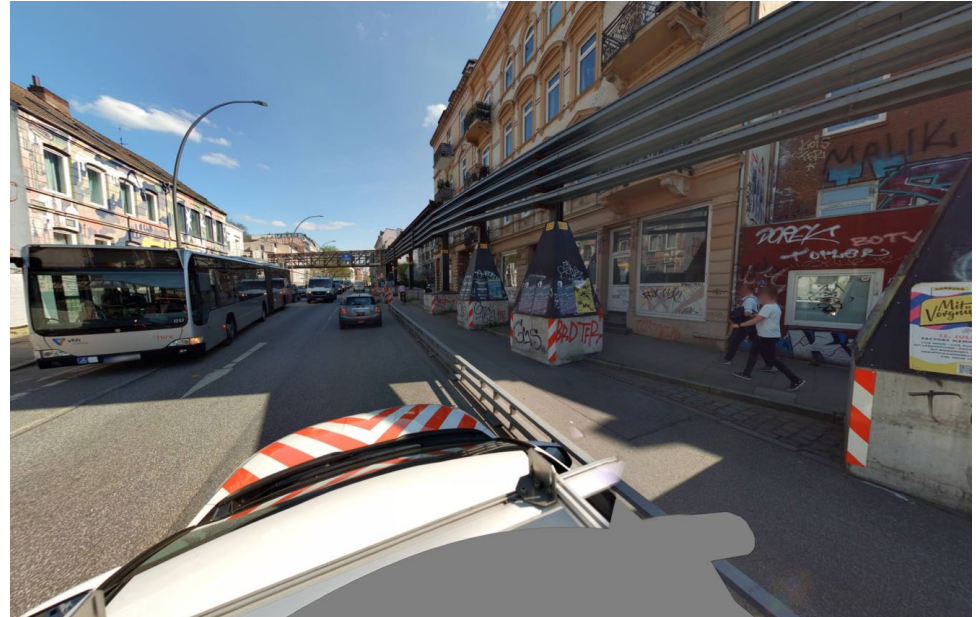
Provisorische Verkehrsführung im Bereich der Kabelhilfstrasse
