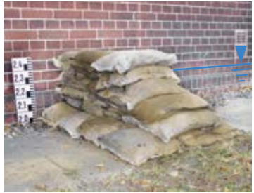
Einfacher Sandsackdamm
